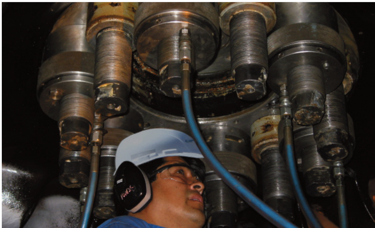
Trabajos de mantenimiento: Cambio de rodete
