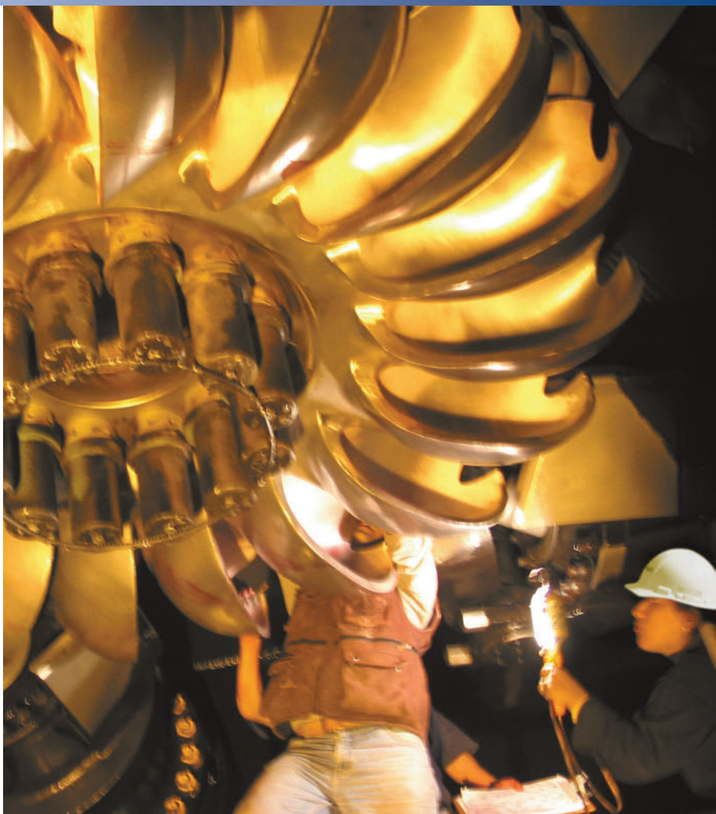
Trabajos de mantenimiento: Inspección de rodete pelton
