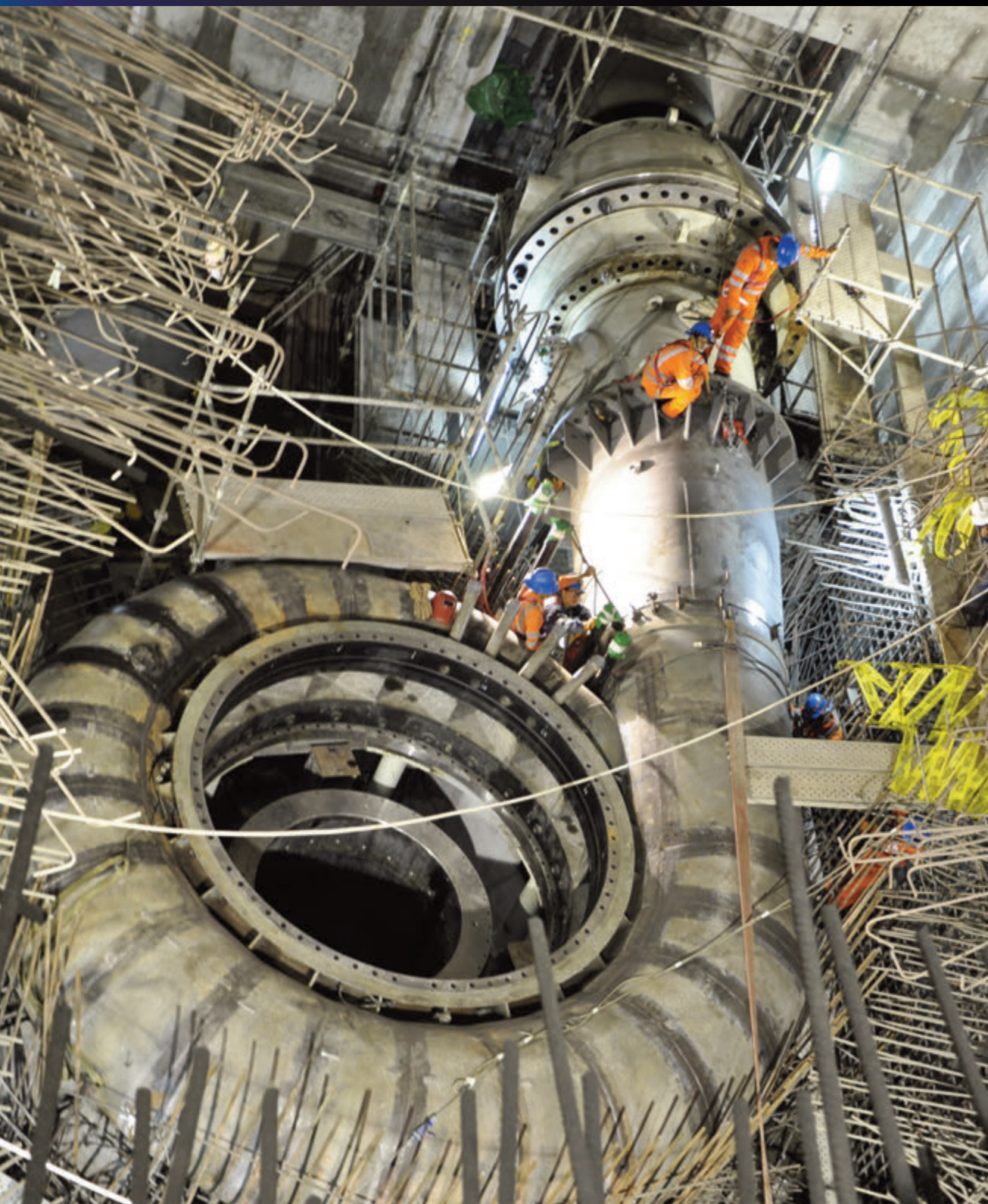
Montaje del caracol de la turbina Francis - Segunda fase, Rehabilitación CH Machupicchu
