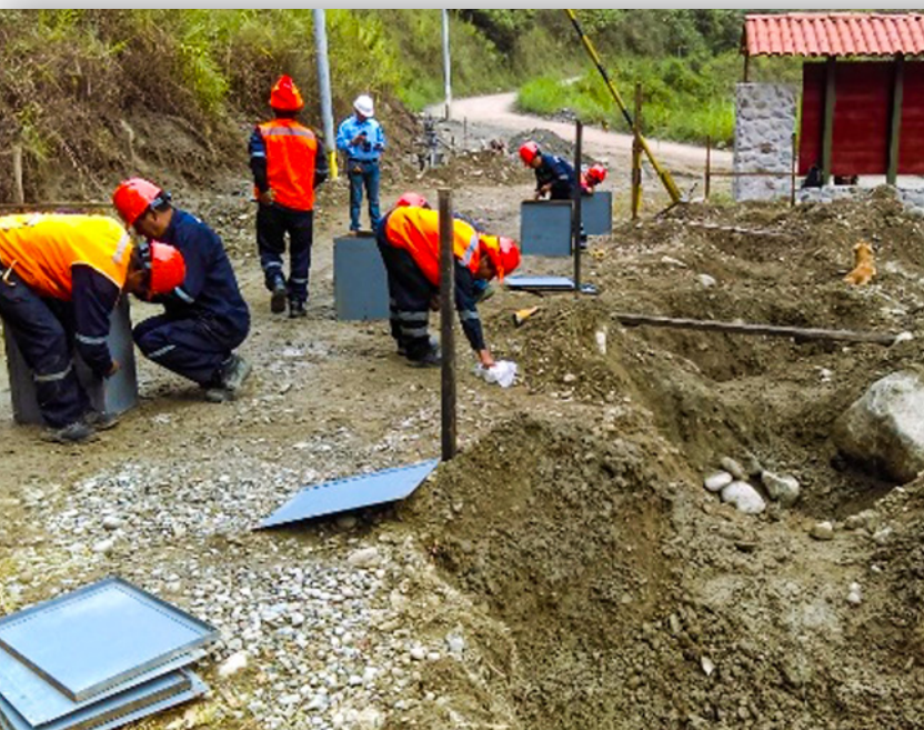
Inicio de obras – Excavaciones
