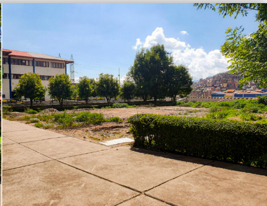
Área de construcción luego de demolición
