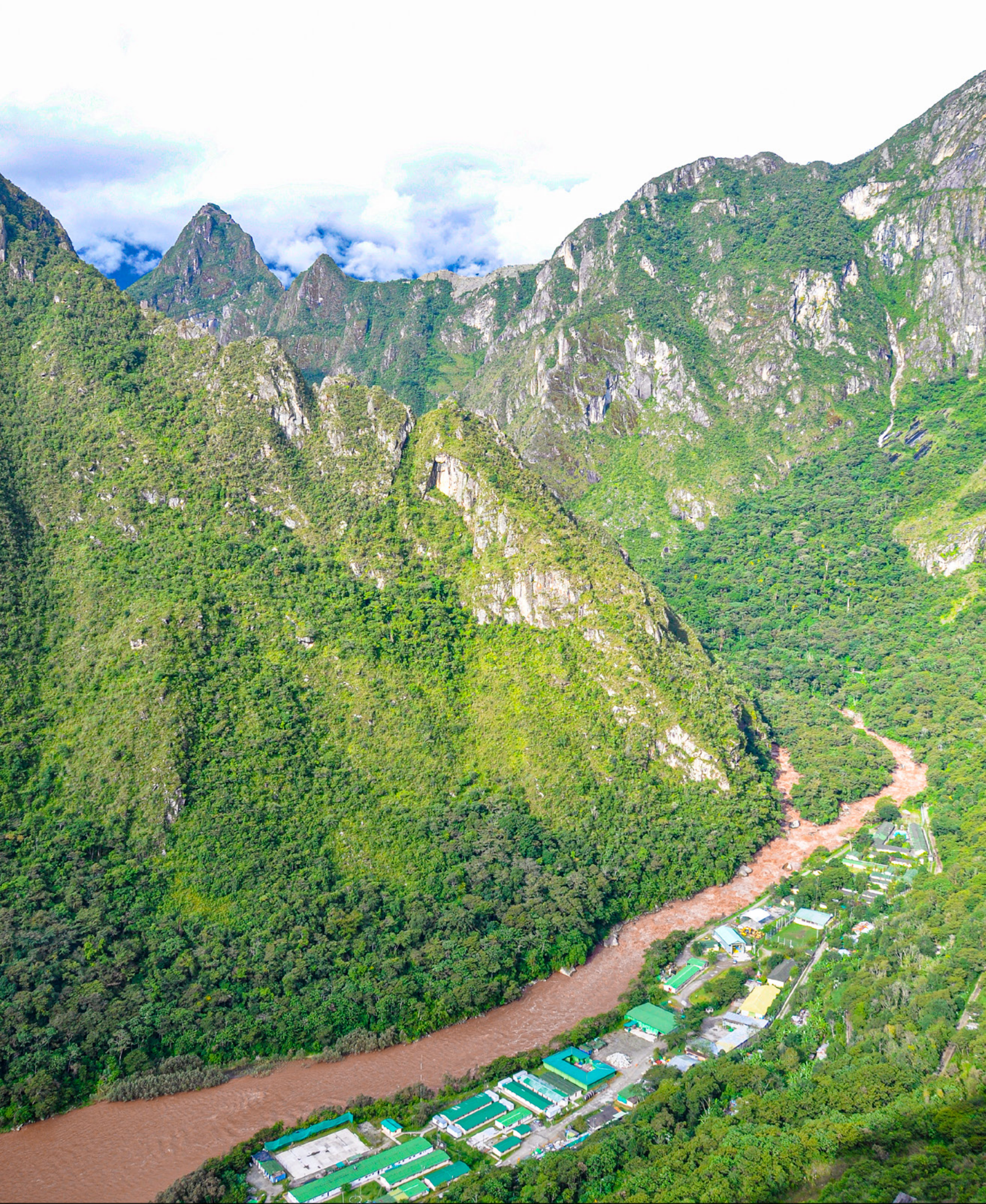
Central Hidroeléctrica Machupicchu
