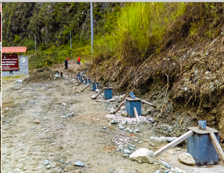
Inicio de obras – Dados de concreto
