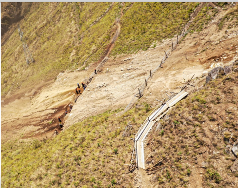
Construcción de accesos a zona de derrumbe y obras
