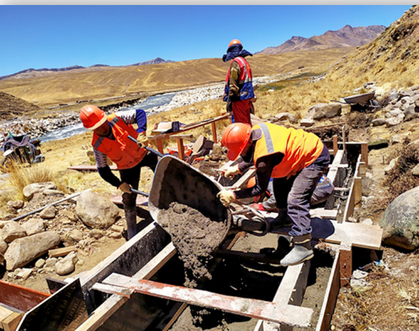
Construcción de sedimentador derivación río Sibinaccocha
