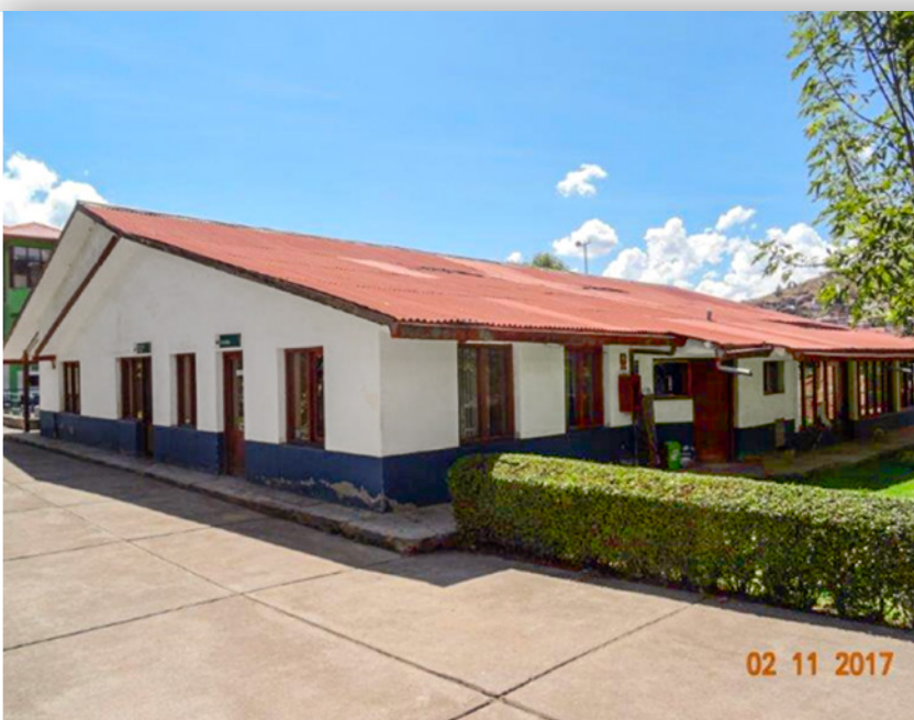
Edificio de adobe antes de demolición
