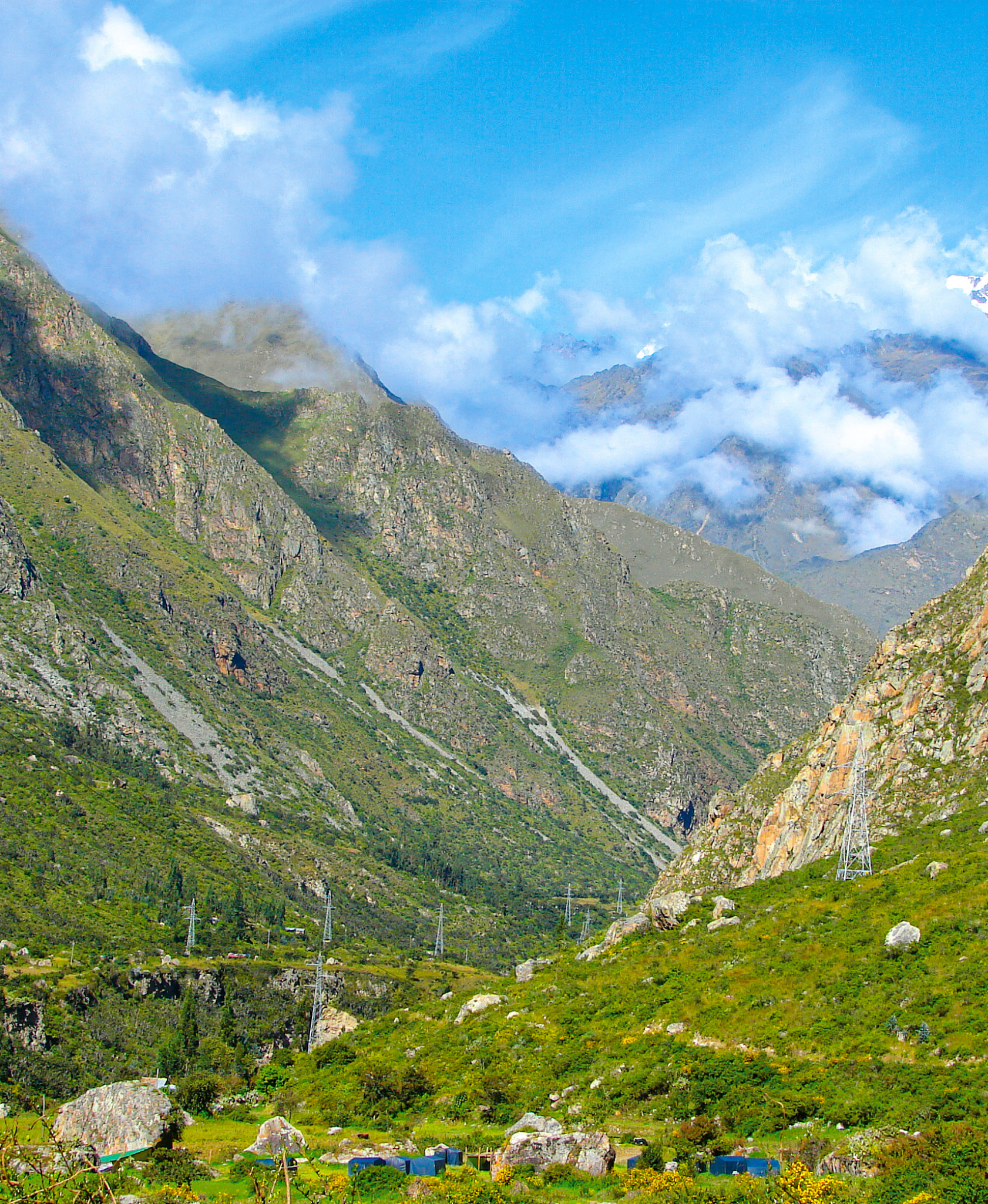
Líneas de transmisión
