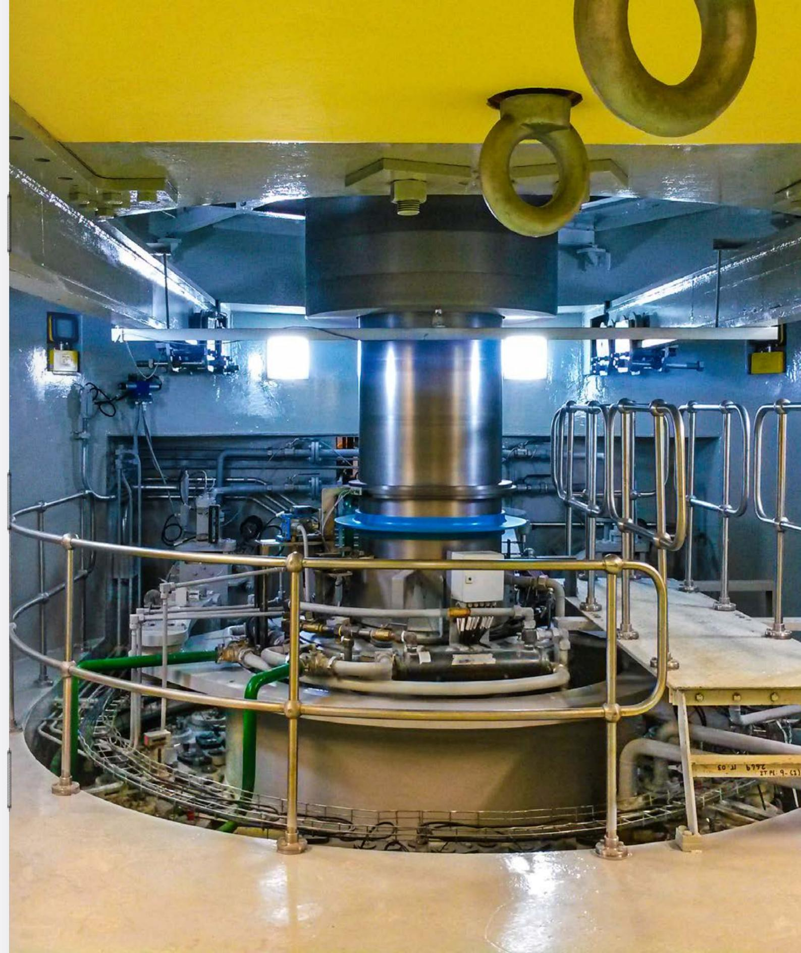
Eje de transmisión de Tubería a Generador - Central Hidroeléctrica Machupicchu
